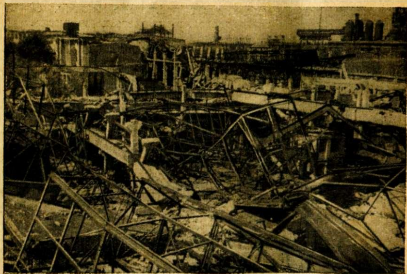
Разрушенный немцами сталеплавильный цех № 2
